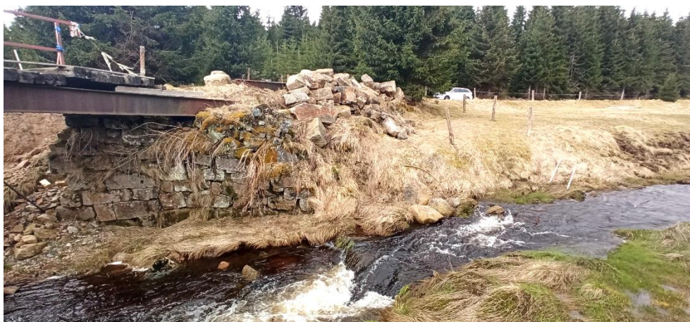
Pohled na pravobřežní kamennou opěru
