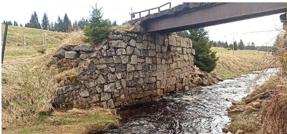
Pohled na levobřežní kamennou opěru
